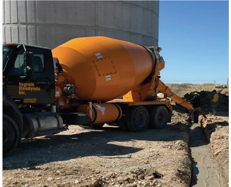
EST – Pouring CLSM on Duck Bank
