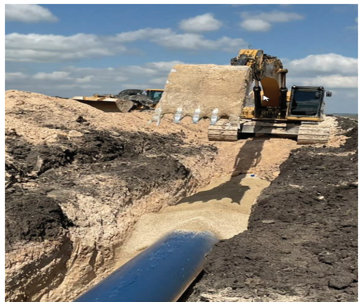
Seg E – Backfilling Pipe
