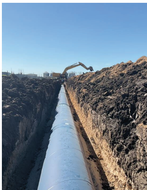
Seg E – Backfilling Pipe
