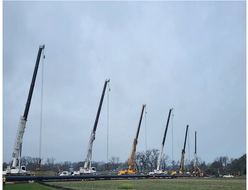
Seg E – HDD Pipe Lift
